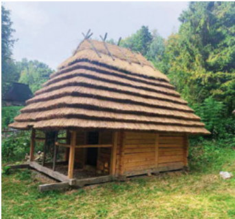
Abb. 22: Freilicht-Museum in Lviv, stufenweises Deckung mit Reet, 40–60 cm dicke Wände aus Schilf
