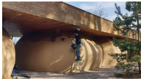
Abb. 14: Verarbeitungsprozess mit Lehmdekorputz © Glinko
