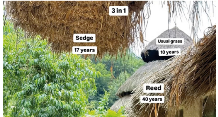
Abb. 26, 27: Haus aus lokalen Naturmaterialien und Übersicht über die verwendeten Materialien und ihre jeweilige Langlebigkeit © Mark Melnychenko
