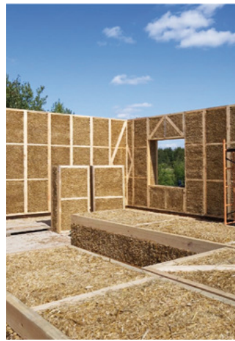
Abb. 18–20: Industriell vorgefertigte strohgedämmte Module © Artem Ryzhkov, Life House Building
