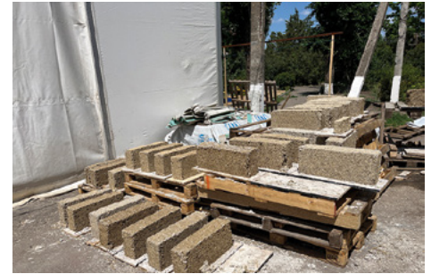
Abb. 3: Hanflager, mobile Trocknungsgestelle und fertige Hanfkalksteine in der Ausstellung ZUR NACHAHMUNG EMPFOHLEN!, Berlin 2023 © Norbert Höpfer
