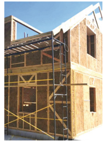
Abb. 18–20: Industriell vorgefertigte strohgedämmte Module © Artem Ryzhkov, Life House Building
