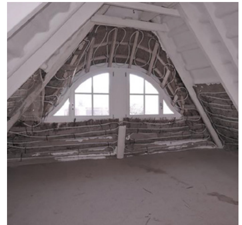
Abb. 19, 20: Multifunktionale mehrschichtige Lösung: Reetdach von Innen mit Lehm verputzt © Elisabeth Endres
