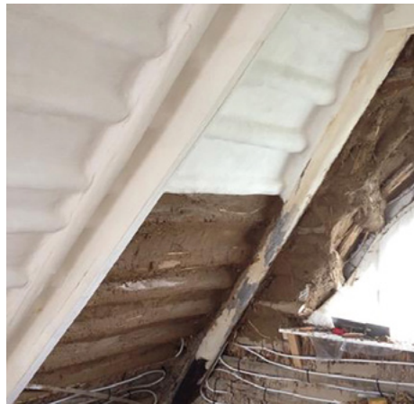
Abb. 19, 20: Multifunktionale mehrschichtige Lösung: Reetdach von Innen mit Lehm verputzt © Elisabeth Endres
