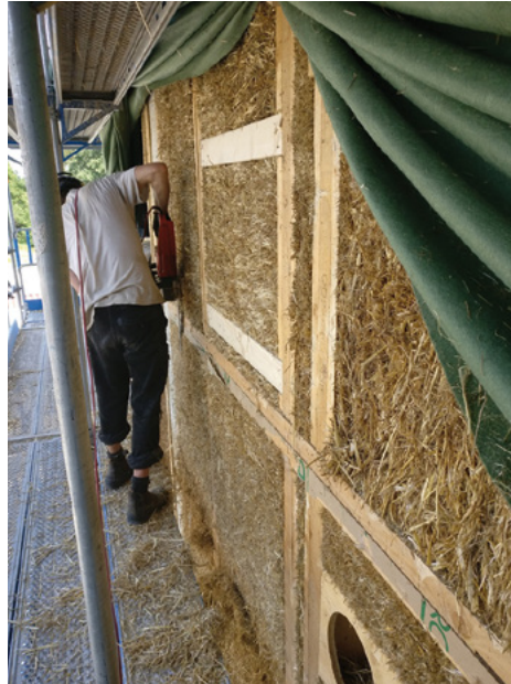
Abb. 9, 10: Strohgedämmte Wandelemente © Adrian Nägel
