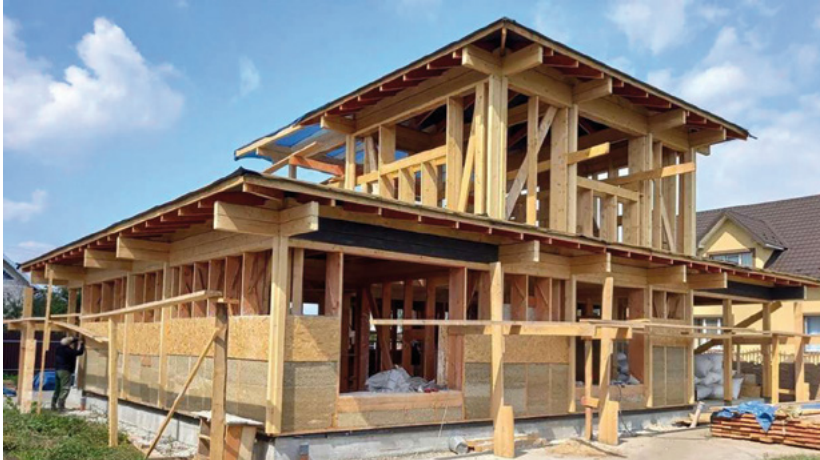
Abb. 16–18: Holzrahmenbau mit Hanfbeton- und Hanfkalk-Ausfächung in verschiedenen Bauphasen © Hempire
