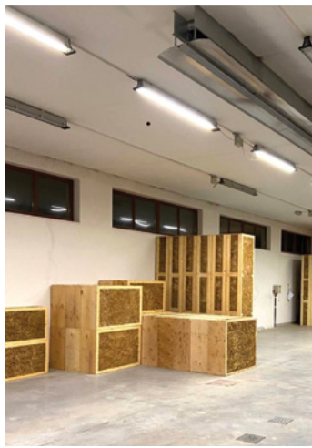
Abb. 18–20: Industriell vorgefertigte strohgedämmte Module © Artem Ryzhkov, Life House Building
