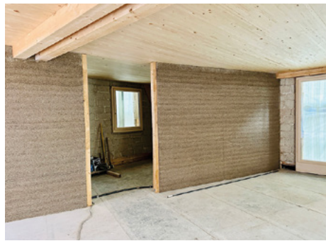
Abb. 23: Wand aus Hanfbeton © www.hanfstein.eu
