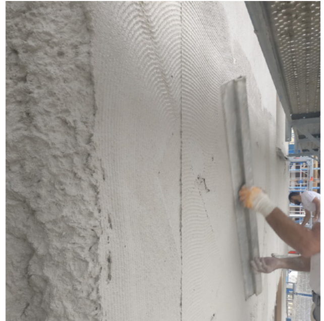
Abb. 13–15: Kalkputzauftrag direkt auf Strohwände © Adrian Nägel
