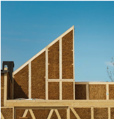
Abb. 21–23: Industrielle vorgefertigte strohgedämmte Module © Artem Ryzhkov, Life House Building
