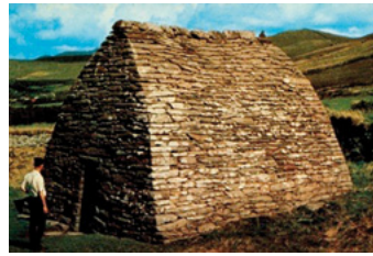
Abb. 1: Trockenmauerwerk aus Steinplatten, frühchristliche Kirche in Irland © Gallarus Oratory, Heritage Ireland, National Monuments Service
