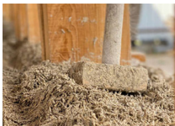
Зоб. 9–12: Виробництво та встановлення будівельних матеріалів з конопель: Змішування, ущільнення та заповнення конопляного вапна в дерев'яних каркасних конструкціях © Hempire
