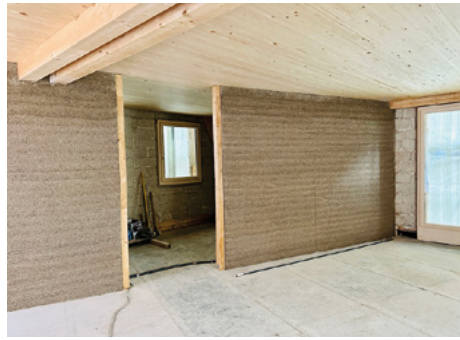
Зоб. 23: Стіна з конопляного бетону © www.hanfstein.eu
