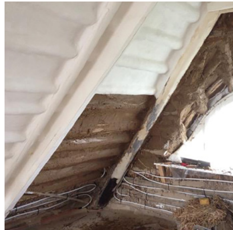
Зоб 19, 20: Багатофункціональне, багат шарове рішення: солом'яний дах, обштукатурений глиною зсередини © Елізабет Ендрес
