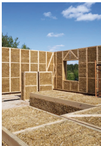
Зоб. 18–20: Промислово збірні модулі з солом'яною ізоляцією © Артем Рижков, Life House Building
