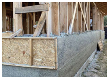
Зоб. 9–12: Виробництво та встановлення будівельних матеріалів з конопель: Змішування, ущільнення та заповнення конопляного вапна в дерев'яних каркасних конструкціях © Hempire
