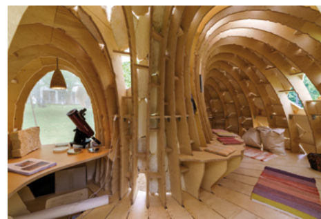
Зоб. 10: Зовнішній та внутрішній вигляд MY-CO SPACE. Вигнутий інтер'єр, виготовлений з фанерних арок, покритих міцелієм © Вольфганг Гюнцель, tinyBE
