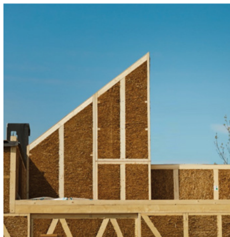
Зоб. 21–23: Промислово збірні модулі з солом'яною ізоляцією © Артем Рижков, Life House Building
