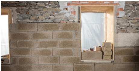
Зоб. 22: Внутрішня ізоляція з конопляних блоків © www.hanfstein.eu
