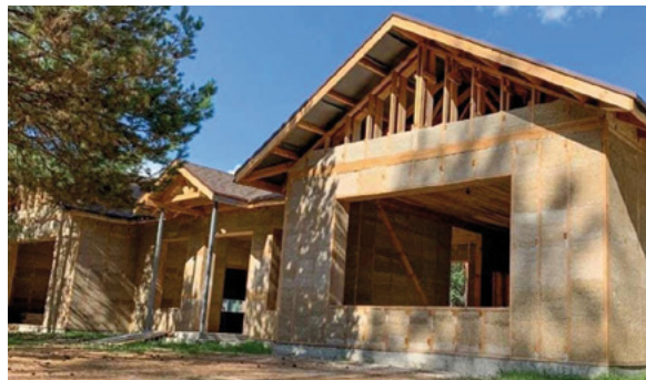
Зоб. 16–18: Дерев'яна каркасна конструкція з конопляним бетоном та конопляно-вапняним заповненням на різних етапах будівництва © Hempire
