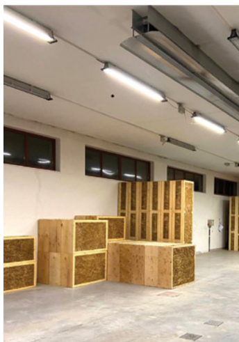
Зоб. 18–20: Промислово збірні модулі з солом'яною ізоляцією © Артем Рижков, Life House Building
