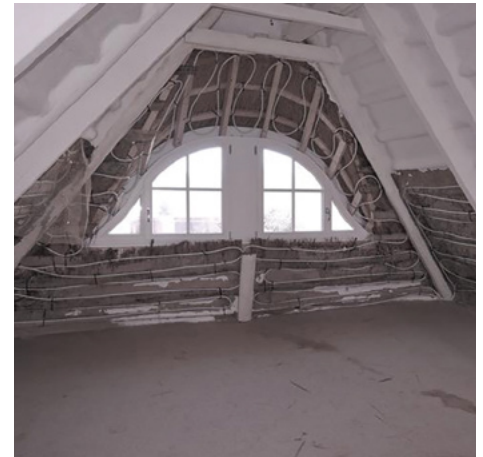
Зоб 19, 20: Багатофункціональне, багат шарове рішення: солом'яний дах, обштукатурений глиною зсередини © Елізабет Ендрес
