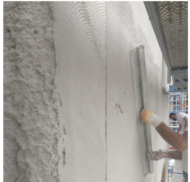
Зоб. 13–15: Вапняна штукатурка, нанесена безпосередньо на солом'яні стіни © Адріан Негель
