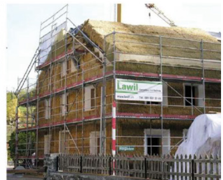
Зоб. 4–6: Приклад: Atelier Werner Schmid – швейцарська архітектурна фірма, що спеціалізується на сталому будівництві з використанням натуральних будівельних матеріалів, таких як солома та дерево, проєктуючи теплоефективні, низькоенергетичні будівлі © https://www.atelierschmidt.ch/oekologie
