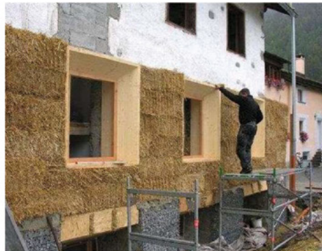
Зоб. 4–6: Приклад: Atelier Werner Schmid – швейцарська архітектурна фірма, що спеціалізується на сталому будівництві з використанням натуральних будівельних матеріалів, таких як солома та дерево, проєктуючи теплоефективні, низькоенергетичні будівлі © https://www.atelierschmidt.ch/oekologie
