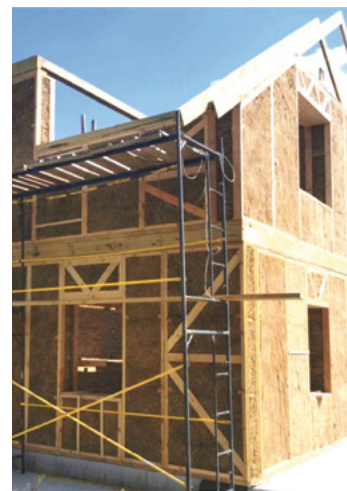
Зоб. 18–20: Промислово збірні модулі з солом'яною ізоляцією © Артем Рижков, Life House Building
