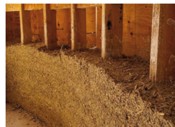
Зоб. 9–12: Виробництво та встановлення будівельних матеріалів з конопель: Змішування, ущільнення та заповнення конопляного вапна в дерев'яних каркасних конструкціях © Hempire
