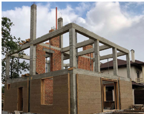
Зоб. 13–15: Різні форми будівель з конопляного бетону, від кубічних до склепінчастих конструкцій у будівництві © Hempire
