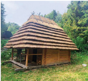
Зоб. 22: Музей просто неба у Львові, техніка ступінчастого покрівельного покриття з очерету; стіни з пучків очерету товщиною 40–60 см
