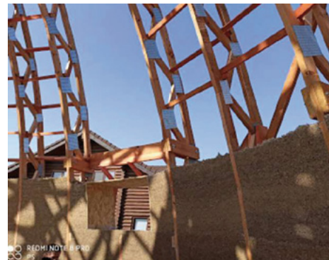
Зоб. 9–12: Виробництво та встановлення будівельних матеріалів з конопель: Змішування, ущільнення та заповнення конопляного вапна в дерев'яних каркасних конструкціях © Hempire
