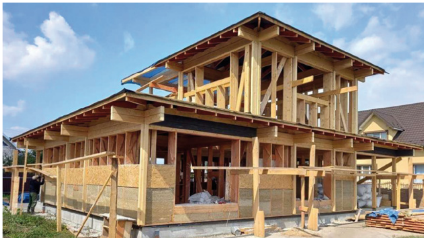
Зоб. 16–18: Дерев'яна каркасна конструкція з конопляним бетоном та конопляно-вапняним заповненням на різних етапах будівництва © Hempire
