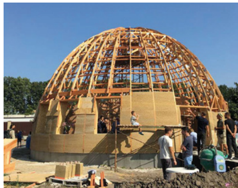
Зоб. 13–15: Різні форми будівель з конопляного бетону, від кубічних до склепінчастих конструкцій у будівництві © Hempire
